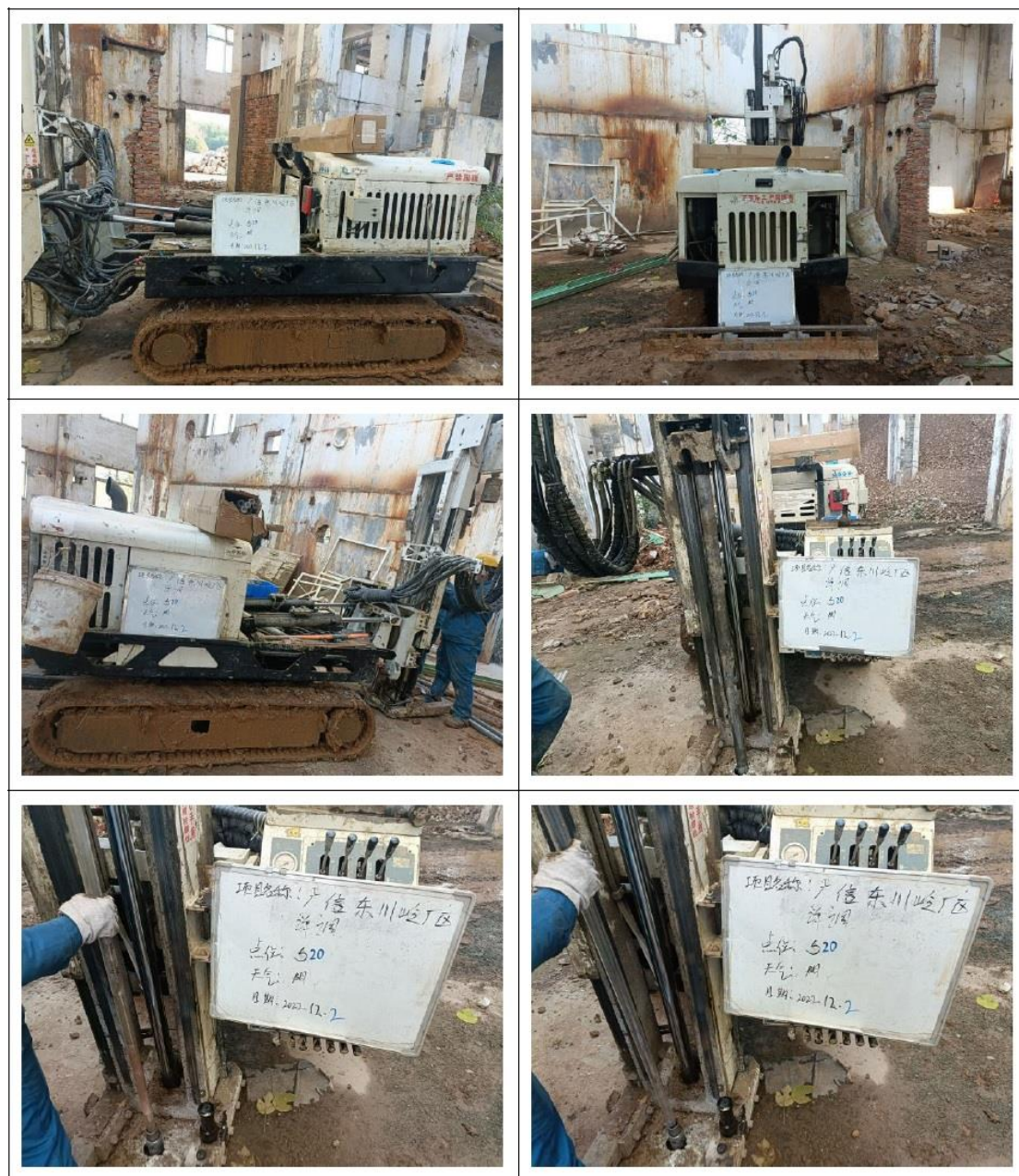
图 5-1-1 土壤钻探过程图
