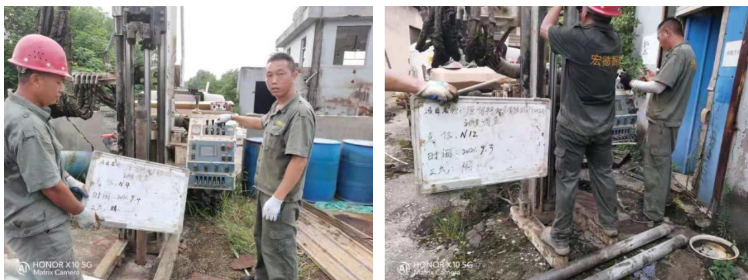
HC-Z450多功能环保钻机设备采集土壤样品
