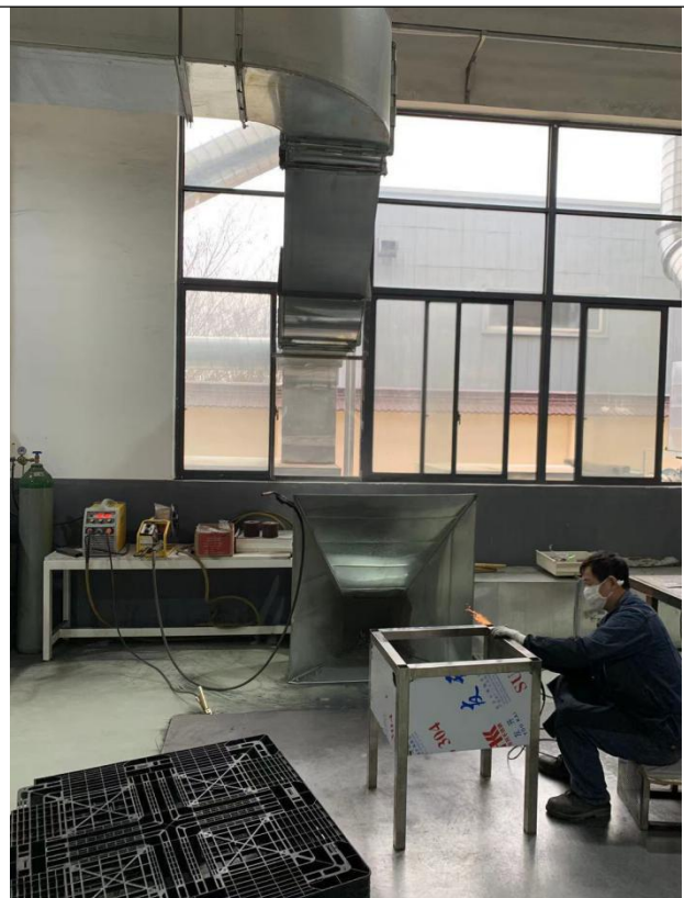
打磨粉尘收集装置
