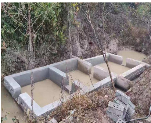
图 7-7 排土场、车辆冲洗沉淀池
