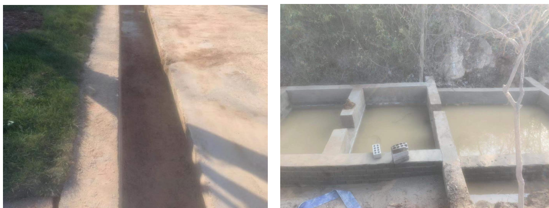
图 7-8 运输道路截排水沟和车辆冲洗沉淀池
