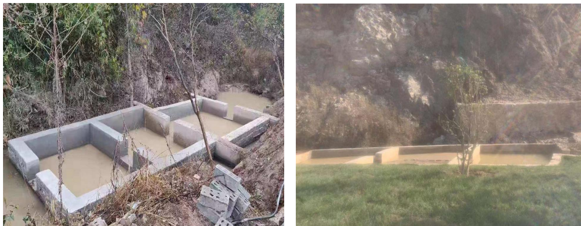
图 8-4 排土场沉淀池、矿区雨排水沉淀池
