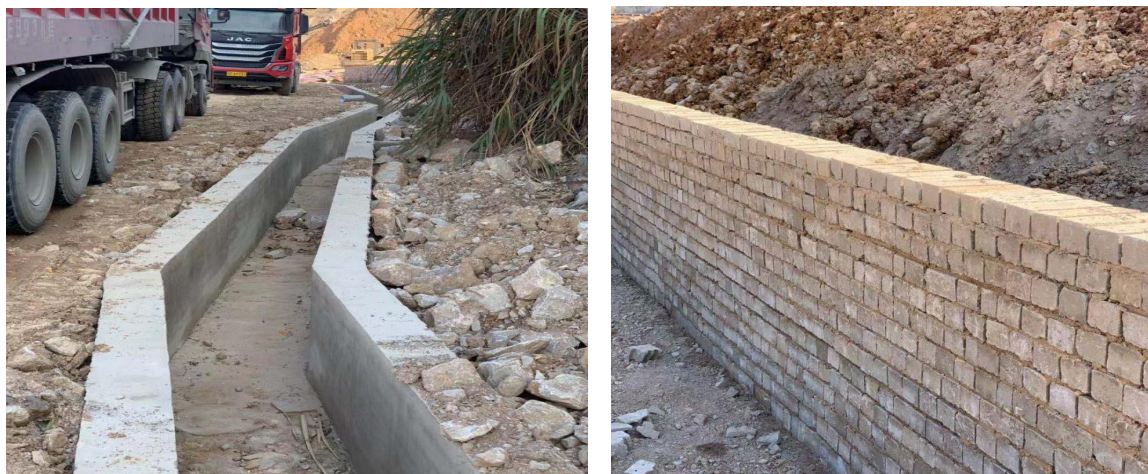
图 7-5 采场雨水三级沉淀池、湿法加工线废水沉淀池
