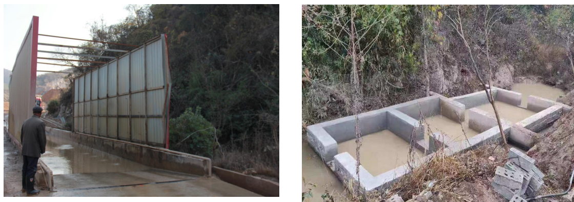
图 8-2 矿山车辆冲洗设施及沉淀池
