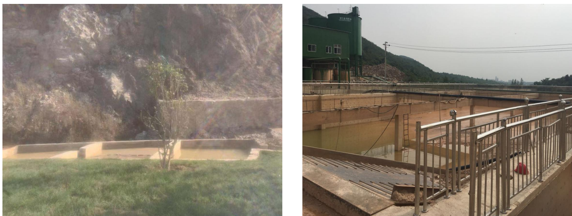
图 7-5 采场雨水三级沉淀池、湿法加工线废水沉淀池
