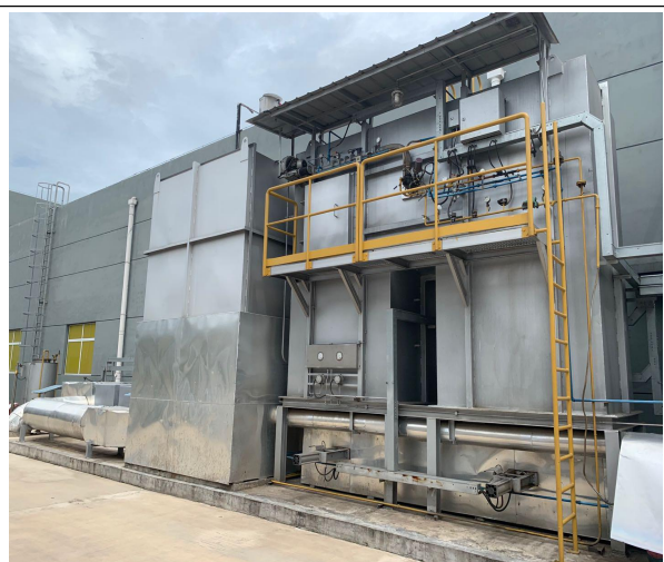
涂布烘干、感光液搅拌废气处理装置（RTO）
