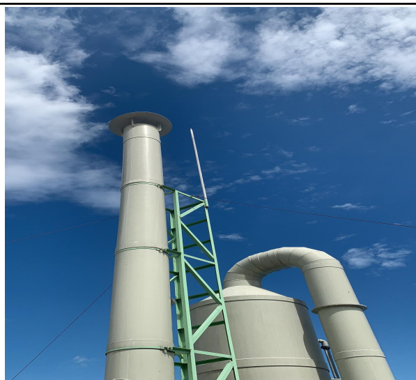
6#生产线酸液喷淋塔
