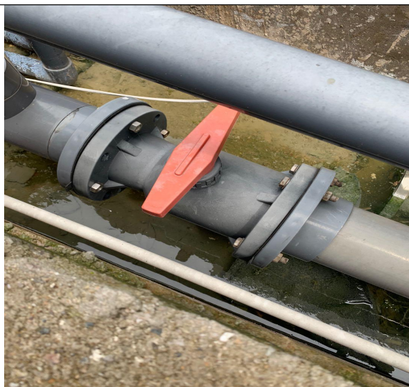
硫酸、盐酸、液碱储罐区及截流阀
