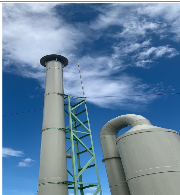
6#生产线 2 号碱液喷淋塔
