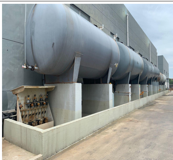
硫酸、盐酸、液碱储罐区及截流阀
