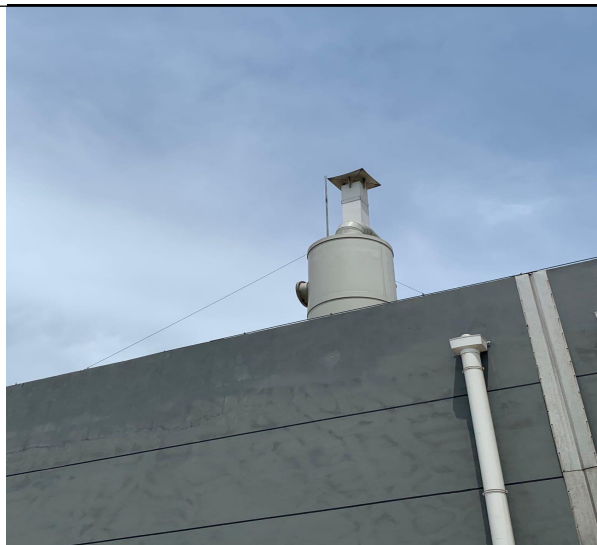
5#生产线 2 号碱液喷淋塔
