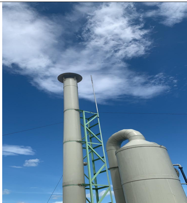
6#生产线 1 号碱液喷淋塔
