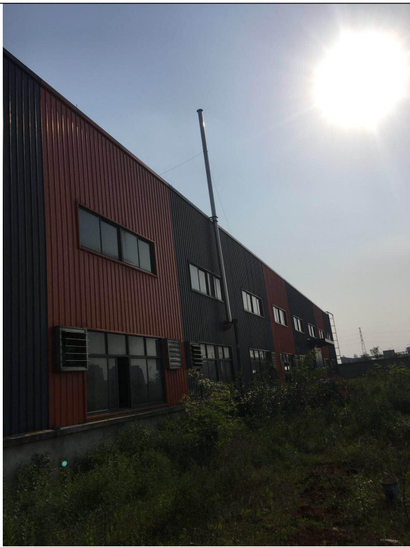
图 4-5 烘烤废气排气筒
