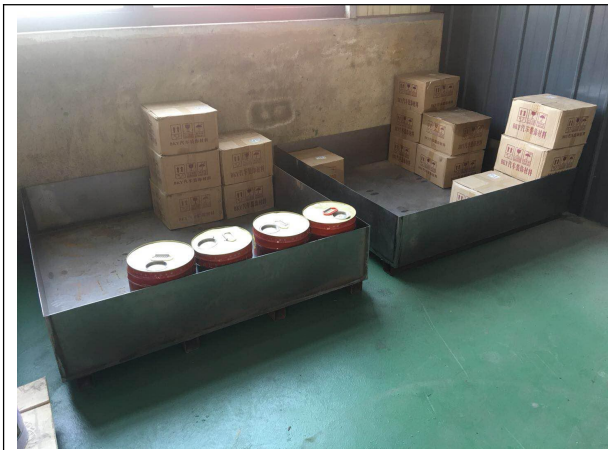
图 4-8 化学品库防渗漏托盘
