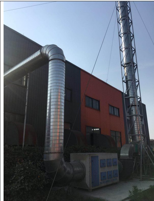
图 4-2 喷漆废气处理设备
