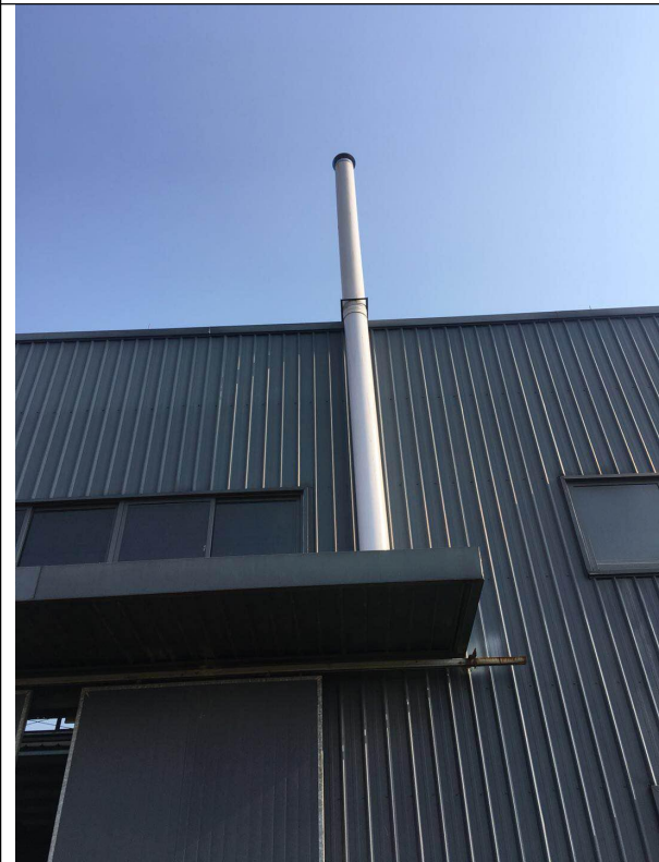
图 4-6 喷塑废气排气筒
