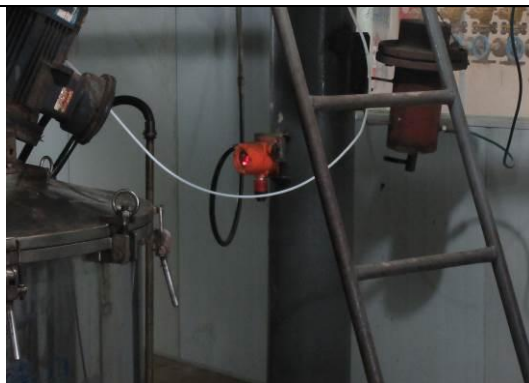
水杨腈可燃气体应急报警装置
