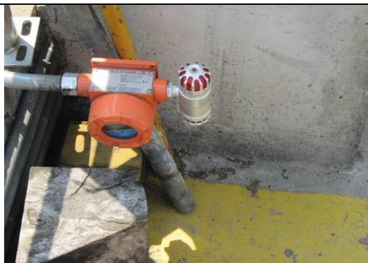
甲基硫菌灵生产车间可燃气体报警器
