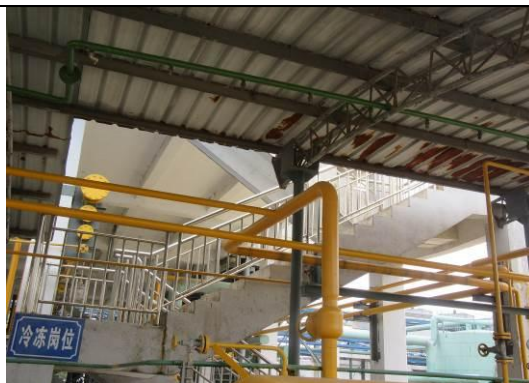
液氨罐区水喷淋
