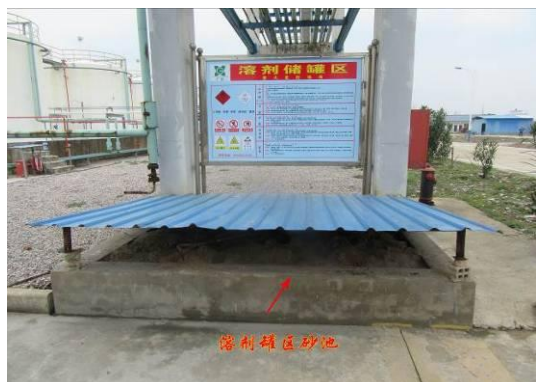
溶剂罐区砂池
