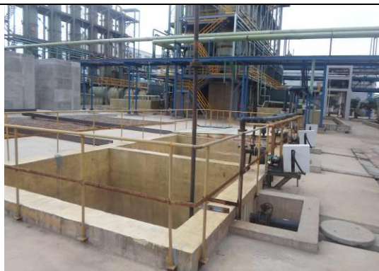
尾破装置废水池及阀门
