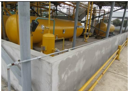
液氨罐区围堰
