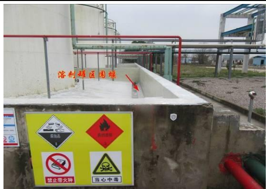
溶剂罐区围堰及内部防腐
