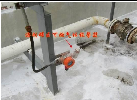
溶剂罐区可燃气体报警器
