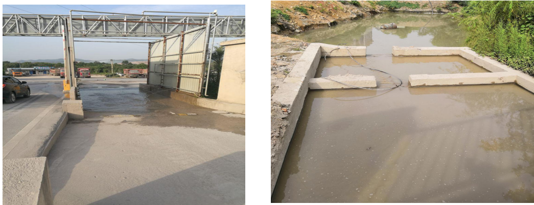
图 8- 2 矿山车辆冲洗设施、二级沉淀池
