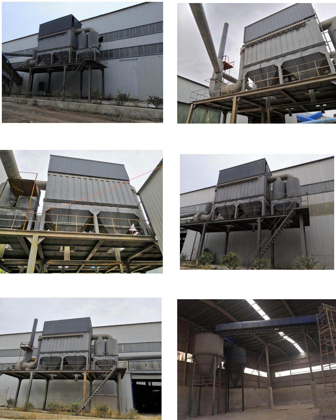
图 9-5 五套袋式除尘器、两根 15m 排气筒、粉料仓
