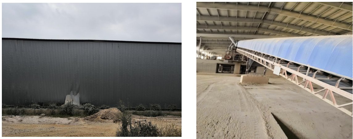
图 9-3 破碎加工区轻钢结构厂房、封闭输送廊道
